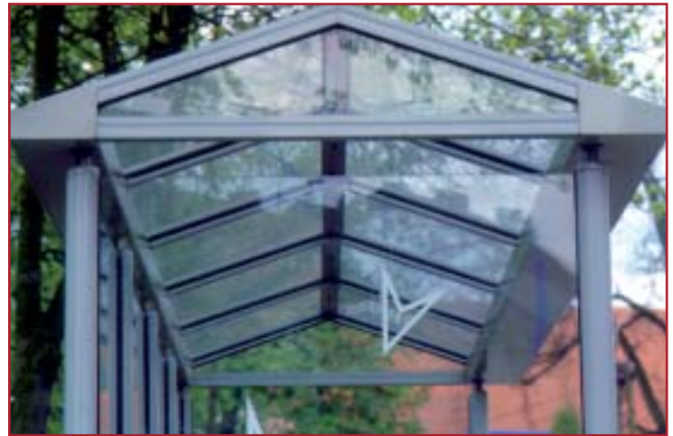
Standort Rheinsberg, Satteldach
