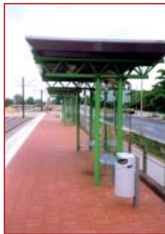
Standort Hannover, Stadtbahn
